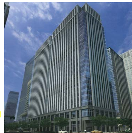
新東京オフィス (東京都代田区丸の内1丁目)
