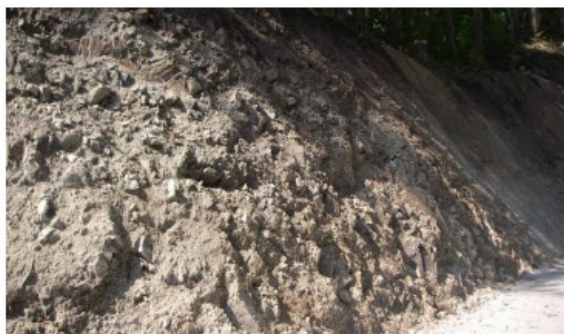
施工前（秋田県の林道工事）
