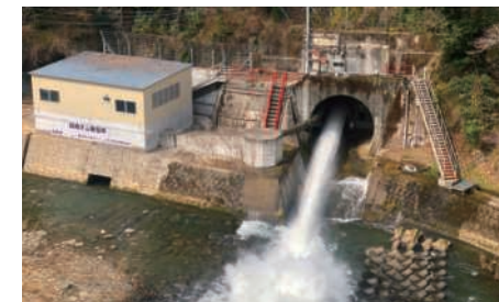
電力を供給する四時ダム発電所
