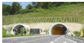
ベトナム ハイバン・トンネル建設事業
