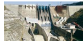
ダム再生事業 写真: 鶴田ダム
