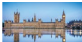
イギリス ウェストミンスター宮殿 改修事業
