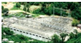
ビルマ パルーチャン水力発電事業
