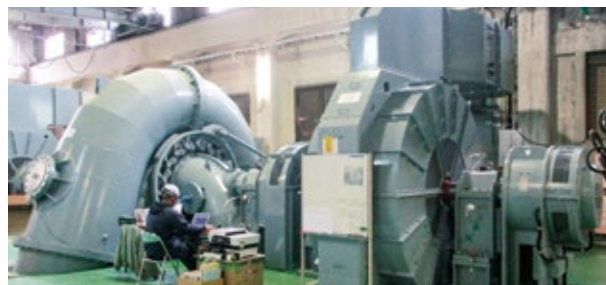
松ノ木発電所1号発電機 更新・水車修理
