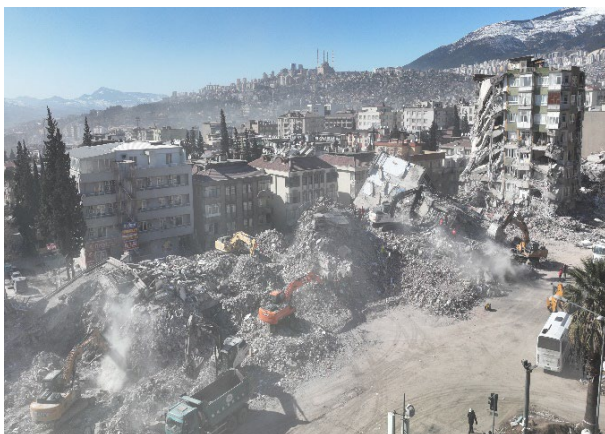
地震被害を受けた街の中心部
