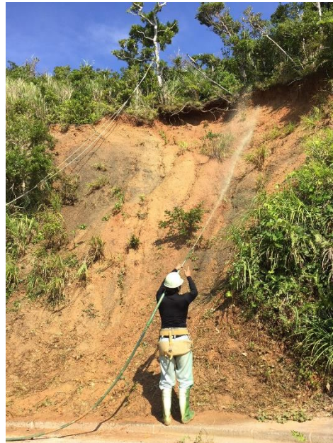
崩壊箇所への BSC 資材吹付
