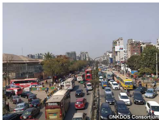
Notun Bazar 駅の建設現場（MRT5号線との接続駅）
