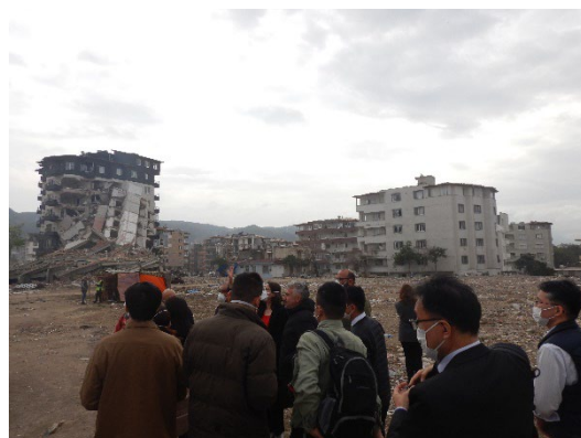
被災した街区全体の状況確認の様子
