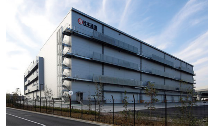
西日本医薬品センター
