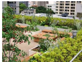
虎ノ門トーセイビル 【2006年築 事務所】
