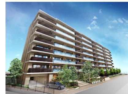
THE パームス戸田マスターグレイス (分譲マンション、全114戸、2022年10月竣工)
