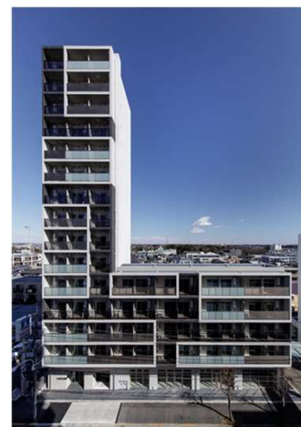
THE PALMS町田 （賃貸マンション全75室）
