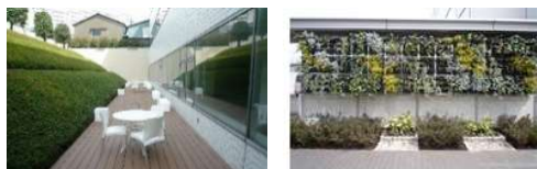
壁面緑化システム導入、ウッドデッキ敷設、LED照明導入、EV防災キャビネット等を実施
