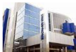
神奈川エリアをカバーする営業拠点 (戸建分譲会社 (株)アーバンホーム)
