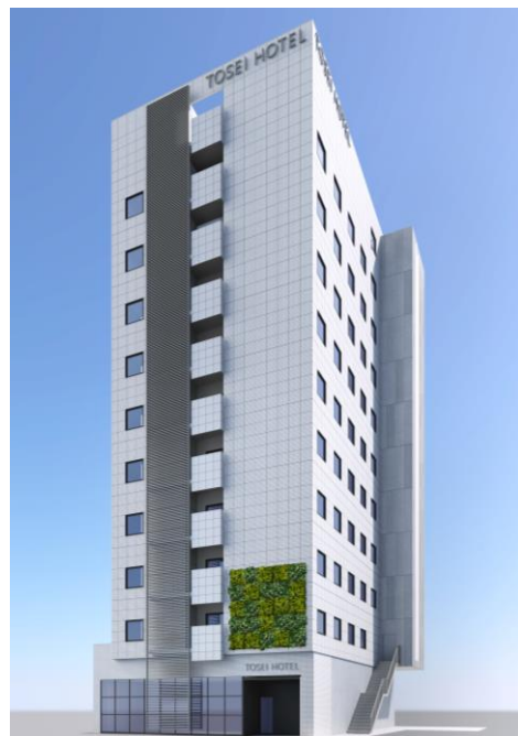
建設中（千代田区内神田） ※画像はイメージであり、変更となる可能性があります
