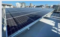
太陽光パネル・蓄電池の設置
