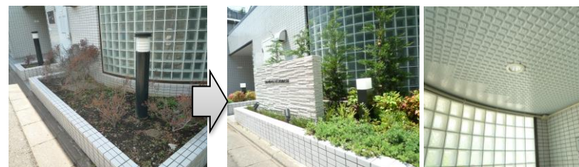
小平市マンションValue Up例 (アプローチ補修、LED照明導入)
