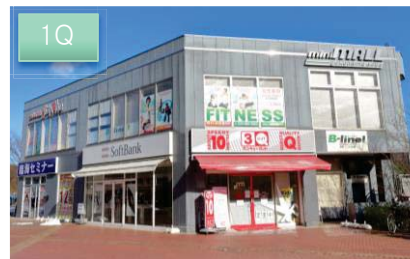
横浜市青葉区 商業施設
