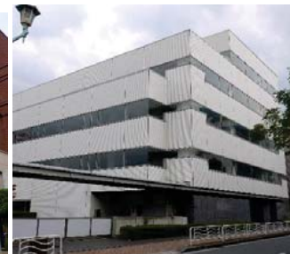
東陽町オフィスビル
