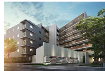
THEパームス調布マノアガーデン(分譲マンション)
