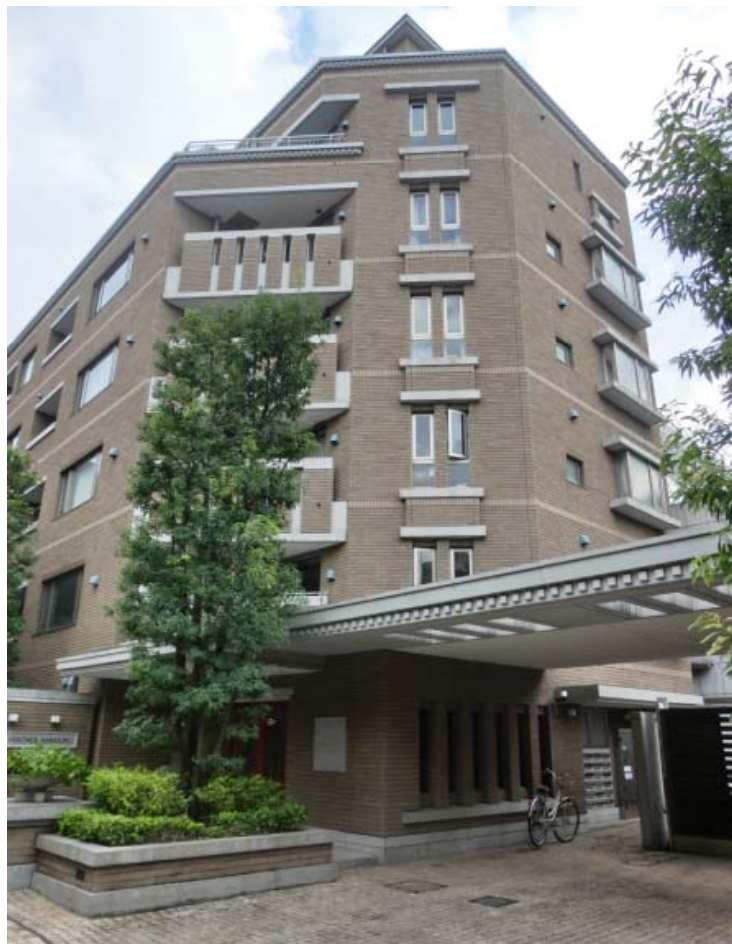
【収益マンション】原宿マンション
