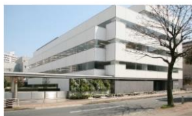
東陽町トーセイビル（1991年築 事務所）
