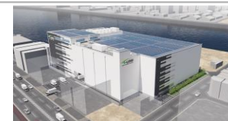
T-LOGI大阪弁天町 （開発中）
