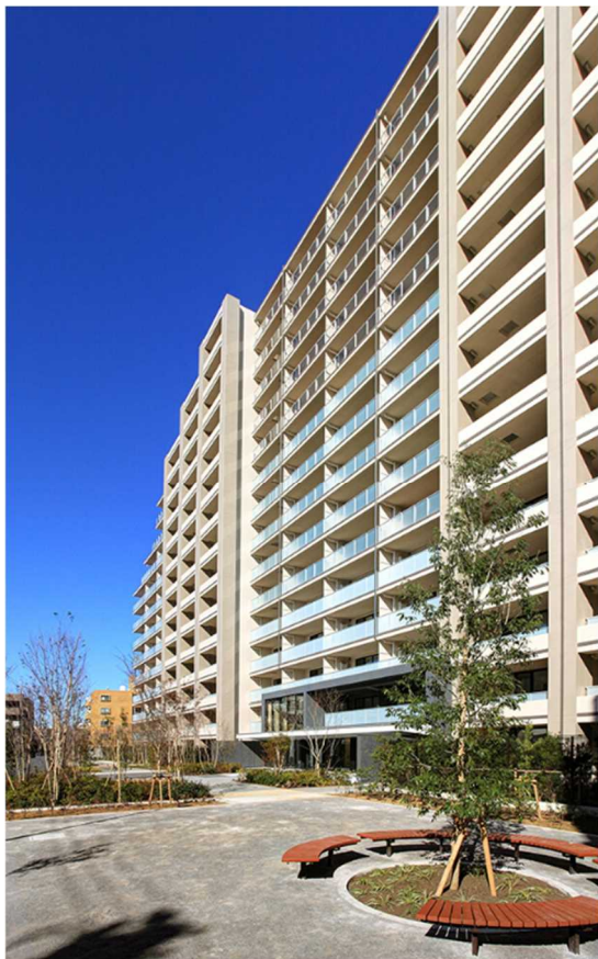
(建物南側外観)
