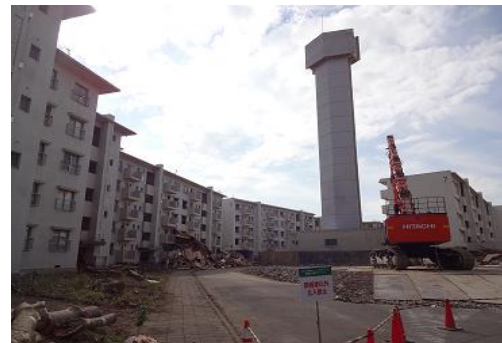
既存建物解体直前の団地内
