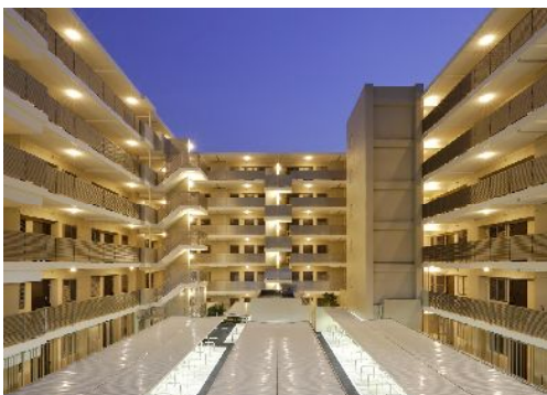
共用廊下のLED照明
