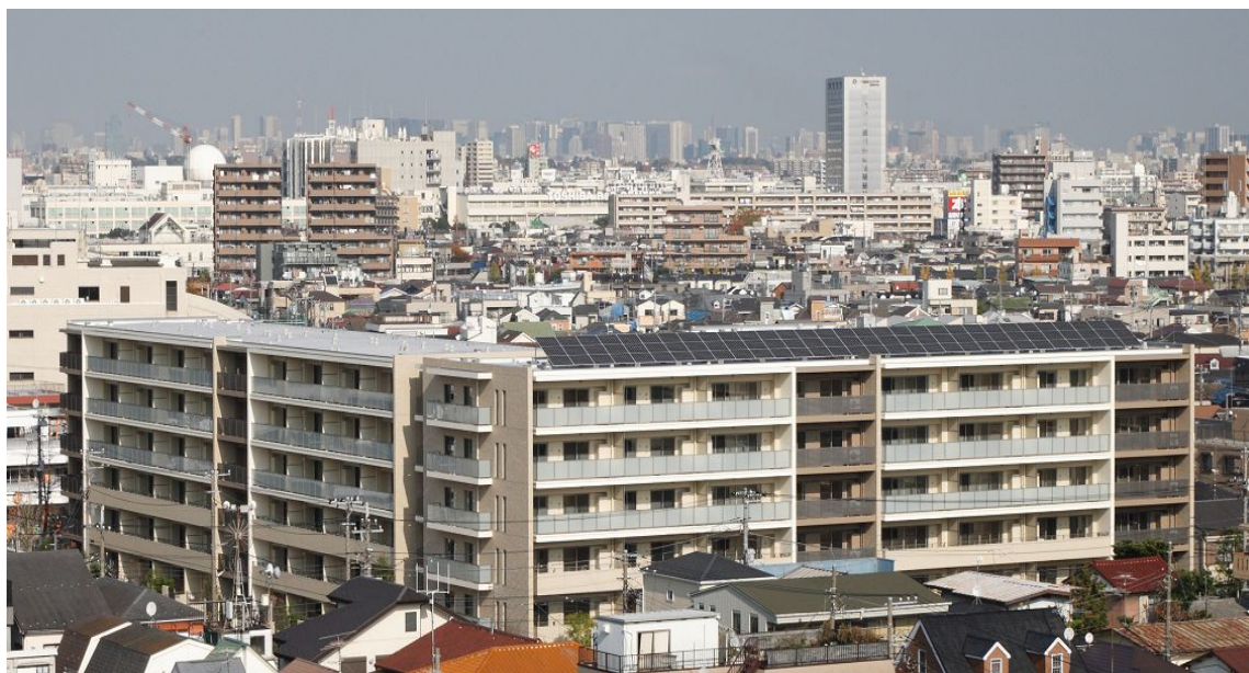
屋上(南棟)に太陽光パネルを設置した「ブリリア イースクエア」
