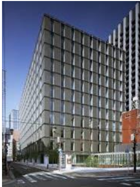
東京建物八重洲ビル
