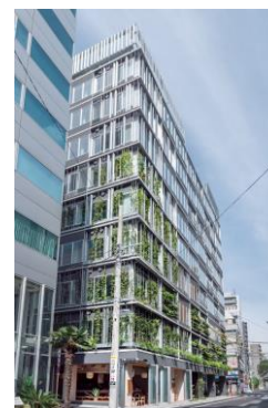
▲ T-PLUS 日本橋小伝馬町 (2022年4月竣工)
