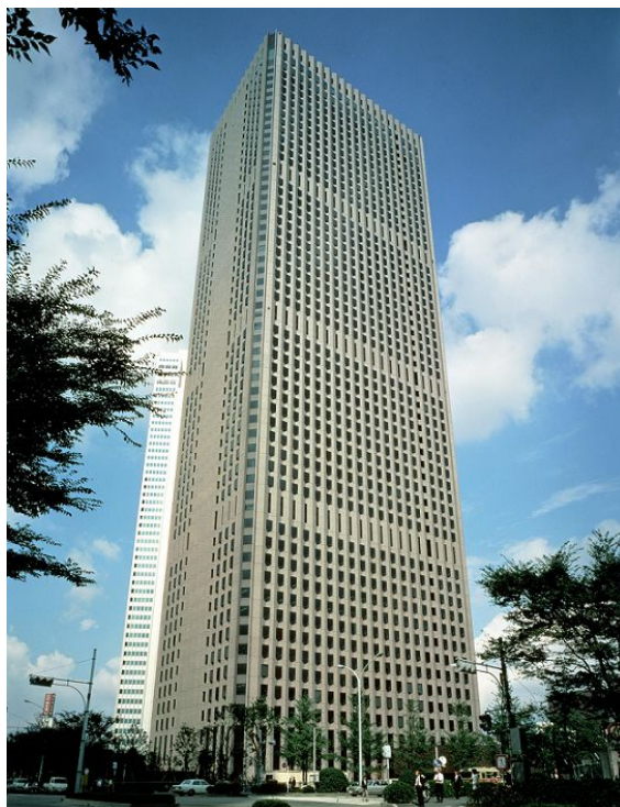
新宿センタービル外観
