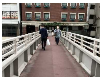
通行幅員が狭い金王坂歩道橋
