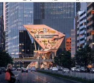
青山通りから見たA街区
