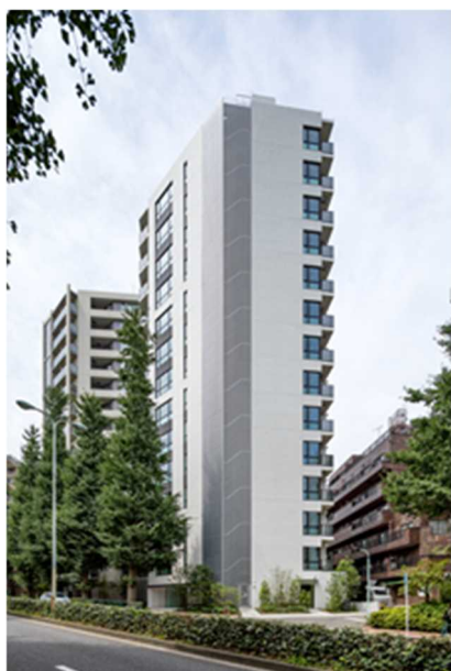
プラチナ通り（外苑西通り）からの外観
