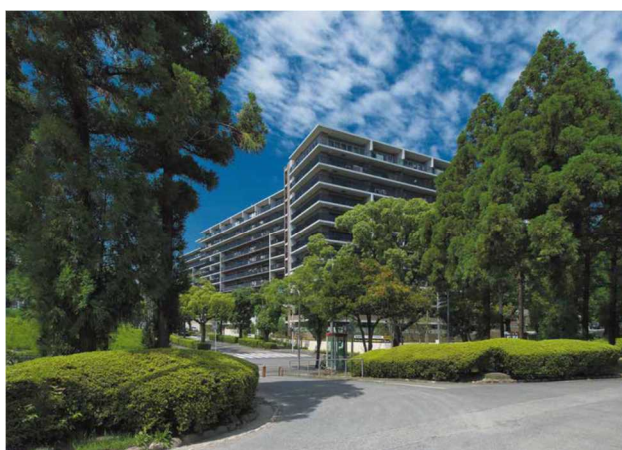
公園より望む本件(近景)
