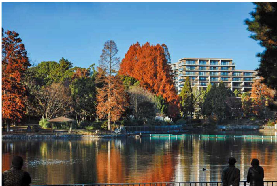
公園より望む本件(遠景)
