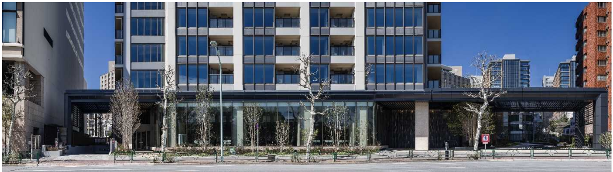
パーゴラ・エントランス外観
