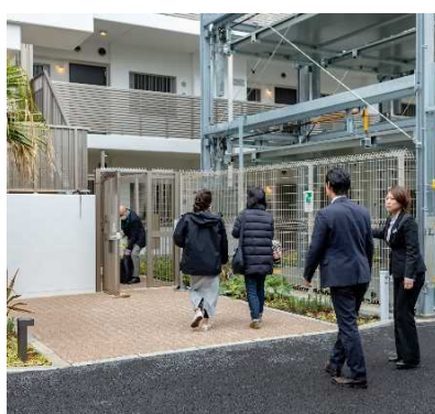
津波避難施設への 1 階階段入口
