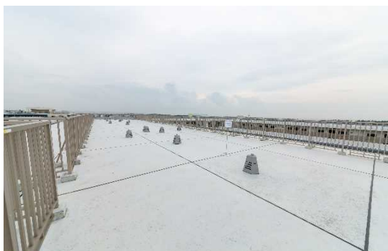
津波避難施設
