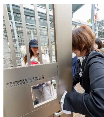
1 階避難階段入口扉
