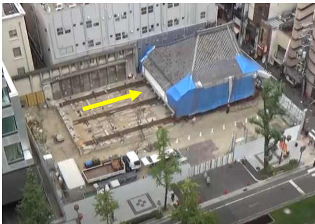
第1回曳家工事（2020.8）
