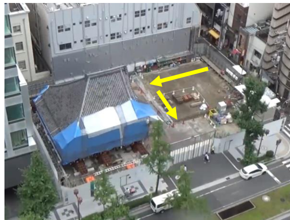
第2回曳家工事（2021.7）
