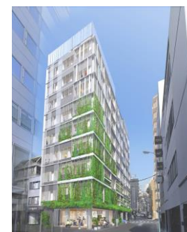
T-PLUS日本橋小伝馬町 (2022年4月竣工)
