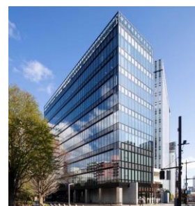
仙台花京院テラス
