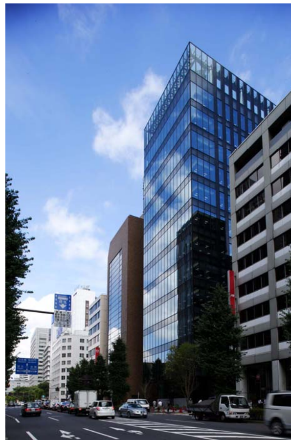
虎ノ門ファーストガーデン (港区虎ノ門一丁目) 地下2階地上12階 延床面積10,154.73㎡ 2010年8月竣工
