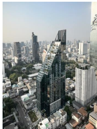
▲ サトーン12PJ (2023年竣工)
