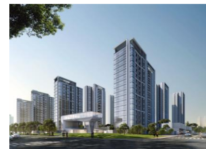
▲ 揚州東PJ (2024年竣工)
