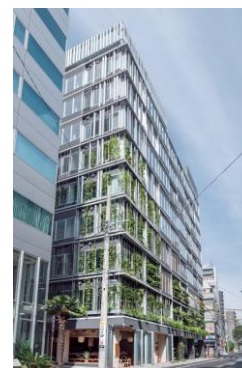
▲ T-PLUS 日本橋小伝馬町 (2022年4月竣工)
