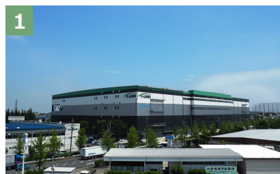
1 T-LOGI久喜 (2020年6月竣工) ⇒満床稼働中。
