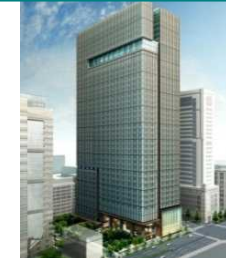
大手町1-6PJ (2013年9月一次竣工予定)
