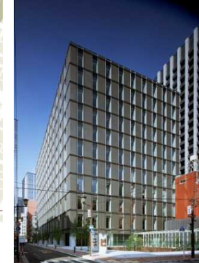
(10)東京建物八重洲ビル
