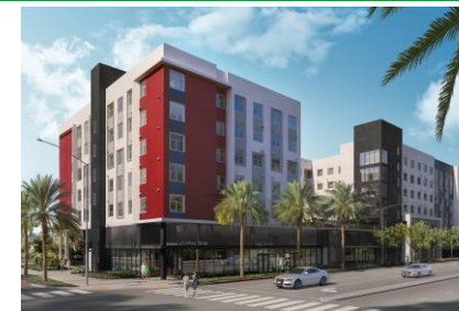
▲ Campanile at SDSU PJ (賃貸住宅) (2028年竣工予定)
