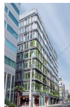
▲ T-PLUS 日本橋小伝馬町 (2022年4月竣工)
