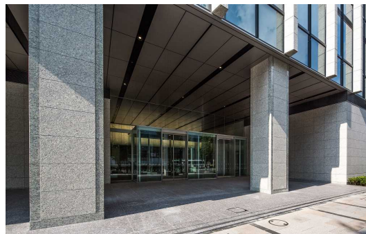
(エントランス外観)
