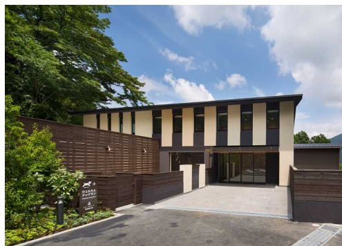
レジーナリゾート箱根仙石原正面アプローチ
