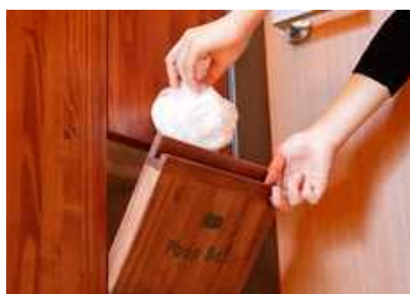
壁面収納型汚物専用ダクト(旧軽井沢にて設置)
