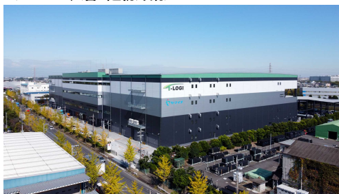
<T-LOGI久喜 建物外観>
