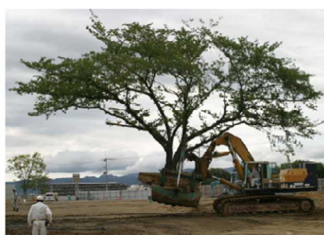
重機を使ったサクラの移植状況
