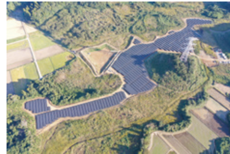
千葉県太陽光発電所
