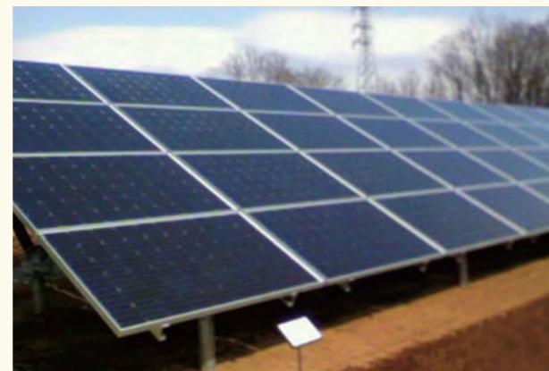
PVG Solutions(株)製 両面で発電できる太陽光パネル
