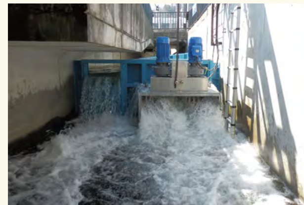
シーベルインターナショナル(株)製 流水式小水力発電装置
