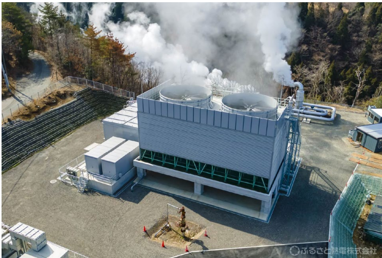
わいた第 2 地熱発電所
