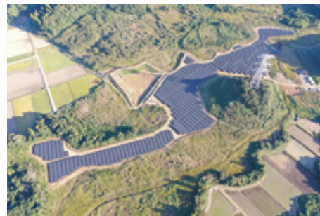
千葉県太陽光発電所
