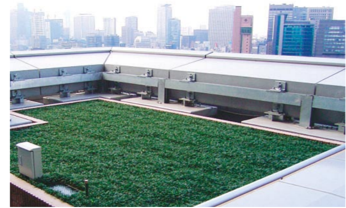
銀座三井ビルの屋上緑化施設
