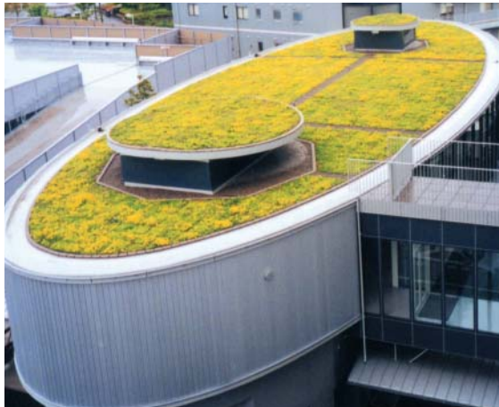
水分を多く含んだセダム類の植え込みトレーを敷き詰めた屋上。(竹中工務店提供)
