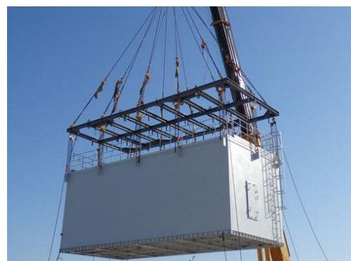
風力発電向け制御盤収納コンテナ
